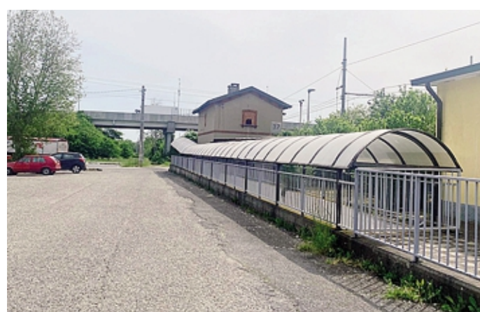
La tettoia del sottopasso della stazione di Vidalengo
