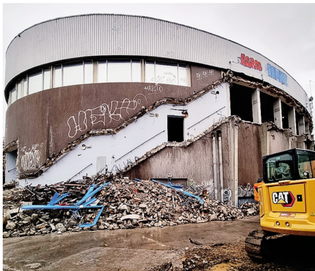
Demolito il corridoio esterno su via Pitentino del Palazzetto dello sport FOTO BEDOLIS
