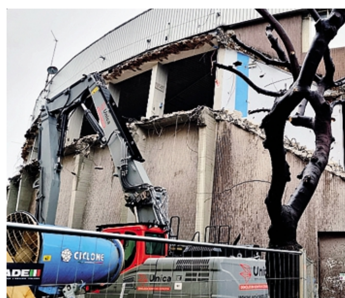
Le «pinze» in azione per lo svuotamento
